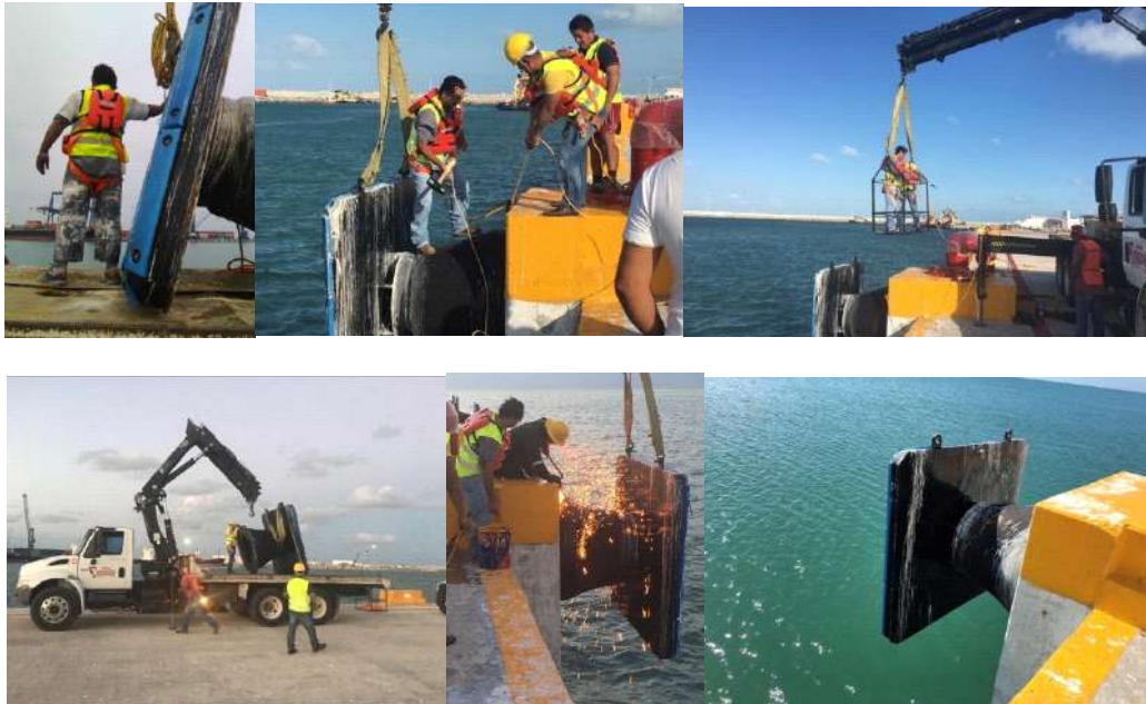
REEMPLAZOS DE TOPES EN MUELLE DE CRUCEROS PROGRESO, YUC.
